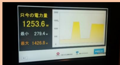
統合パネルで消費電力表示
